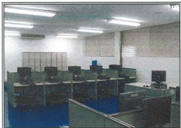
Supervisão/Central de Processamento de Dados
